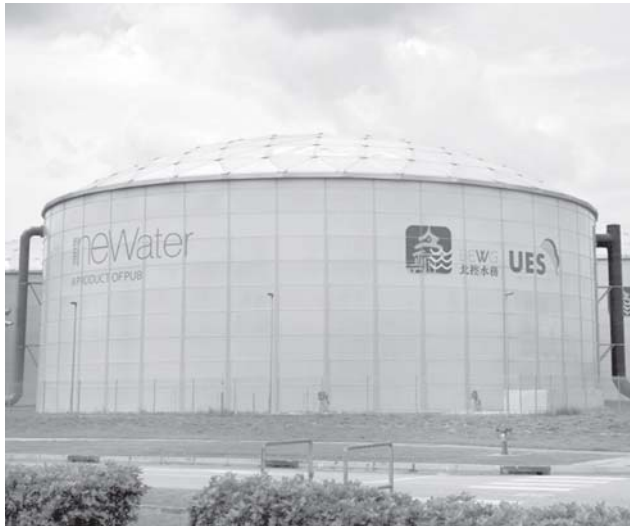
Завод по переработке сточных вод в питьевую в Сингапуре.
